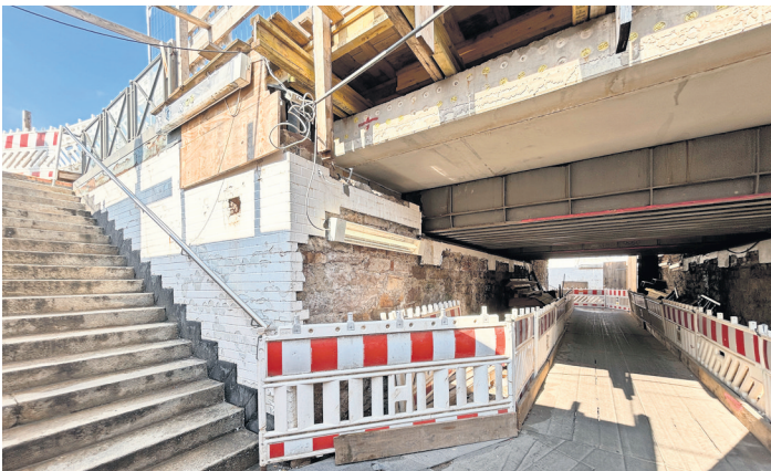
Links geht's über die Treppe zu den Gleisen 1 und 2, rechts durch die Personenunterführung.
